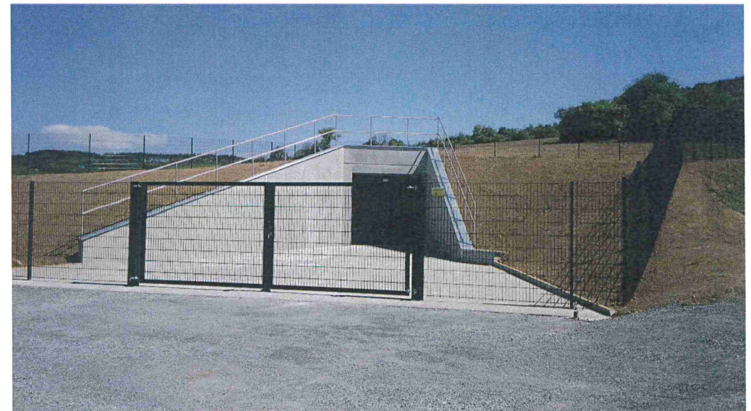
Erdüberdecktes ebenerdiges Abschlussbauwerk
